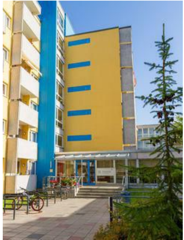
Eingang zur Senioren-Residenz „Hildburghauser Strasse“
