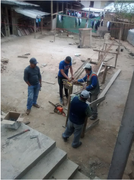
Bauarbeiten am Internat in Santo Tomas
